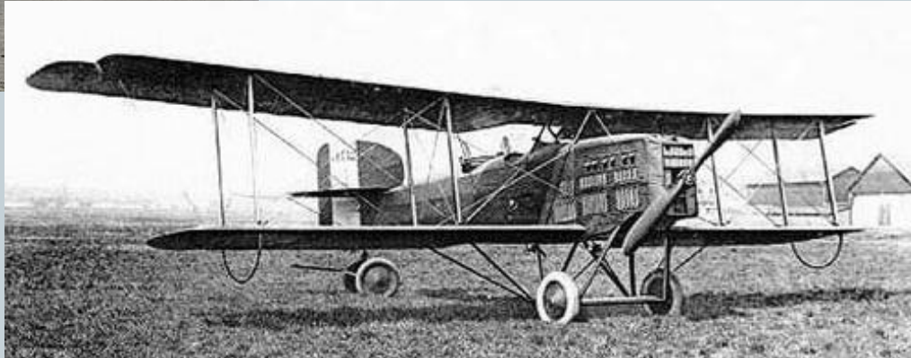
1916: Breguet XIV Début de l'utilisation de Duralumin dans la structure
